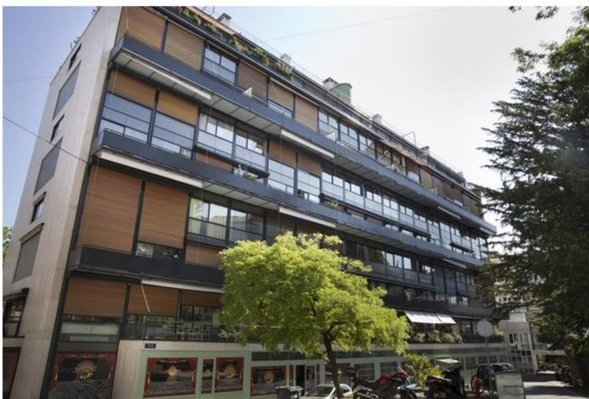
L'immeuble Clarté de Le Corbusier.
