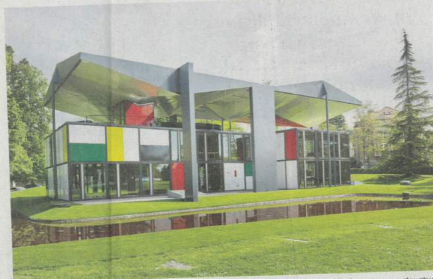
Dernière construction de Le Corbusier, le pavillon bâti dans le parc zurichois se distingue par sa structure de métal et ses panneaux multicolores de métal émaillé. (CHRISTIAN BEUTLER/KEYSTONE)
